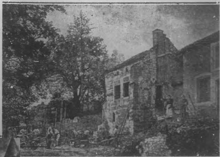
Vaucouleurs (Francia).—Histórica capilla de Juana de Arco en restauración.
